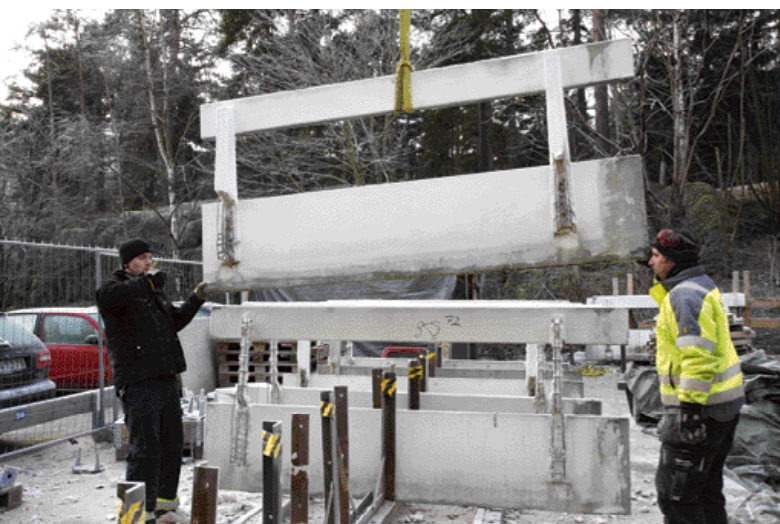
1 ton balkongräcke på väg ner i Diparts tillfälliga renoveringsverkstad. Jätteklössarna ska renoveras till ursprungligt skick. Det har skönhetsrådet bestämt.
