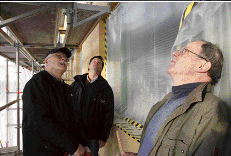
Kolla där då. Vad är det? Hur ser det ut? Thomas Frankborn, och Jarl von Kantzow har fått syn på något intressant under inspektionen av renoveringsarbetet. Mannen i kepsen är föreningens besiktningsman Sune Lindgren.
